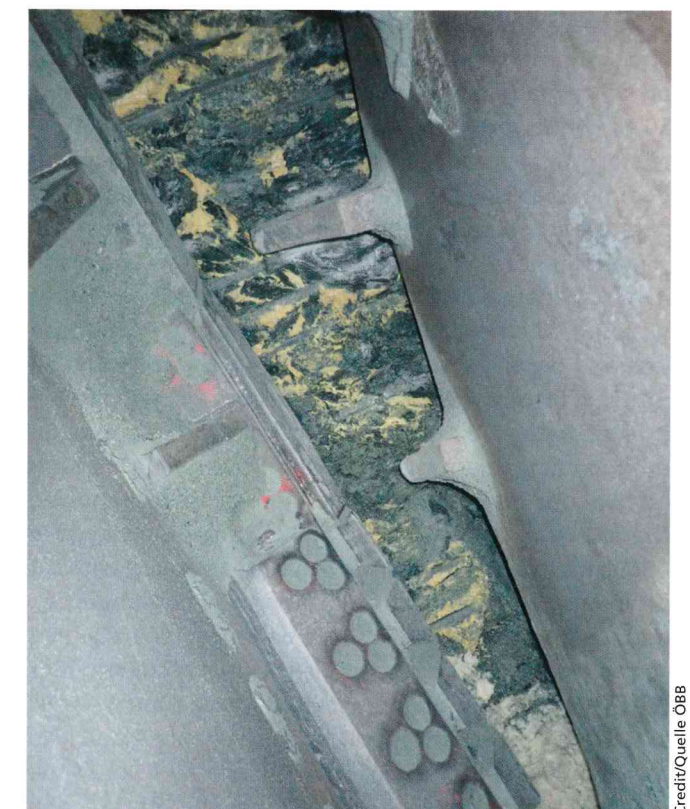
8 View of grouted area through bucket opening Blick aus Räumeröffnung auf injizierten Bereich
