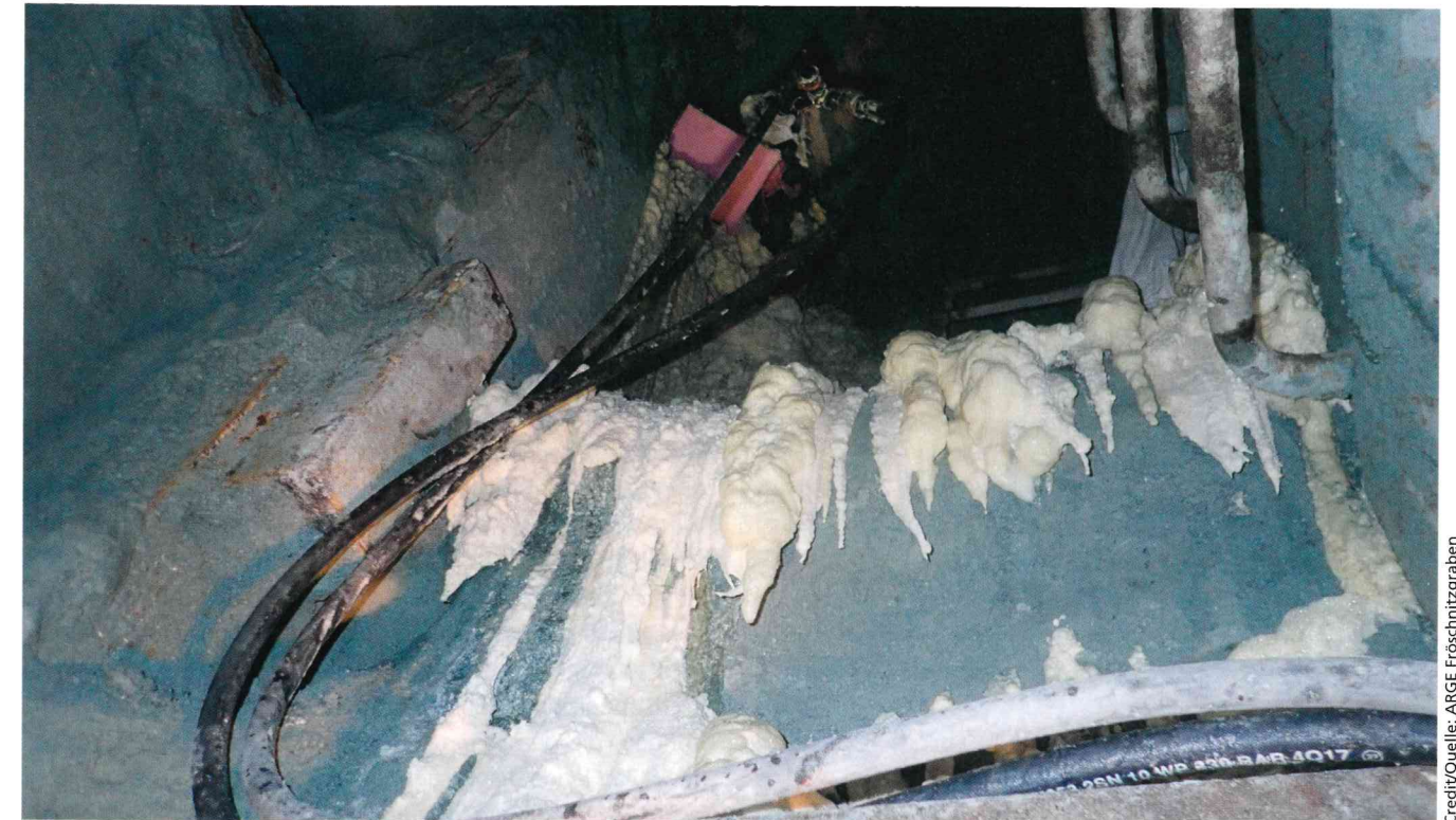
5 Foam injection from cutterhead, TBM 1 Schauminjektion aus Bohrkopf, TVM 1
