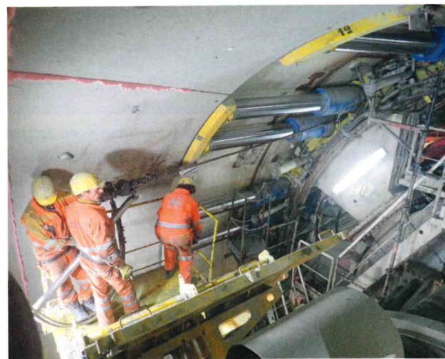
7 Rotary drilling of grouting holes carried out through a drill hole in the shield (for probe drilling or special measure SM3, rock mass improvement with grout screen) Dreh Schlagbohrung zur Herstellung der Injektionslöcher, ausgeführt über eine Bohrgasse im Schild (für eine Erkundungsbohrung oder Sondermaßnahme SM3, Gebirgsvergütung mittels Injektionsbohrschirm)
